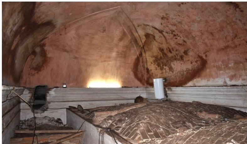
Figura 9: Casa Gavião Peixoto, panorama do actual sótão com as abóbadas de barrete de clérigo originais que sustentam directamente o telhado (acima) e as abobadilhas, também de barrete de clérigo, introduzidas no séc. XIX (abaixo). (foto: Sérgio Costa)
