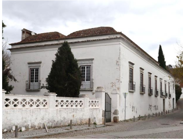
Figura 8: Casa Gavião Peixoto, fachada. Os telhados paralelos sobrepõem-se às duas enfilades de compartimentos abobadados. (foto: Mafalda Pacheco)
